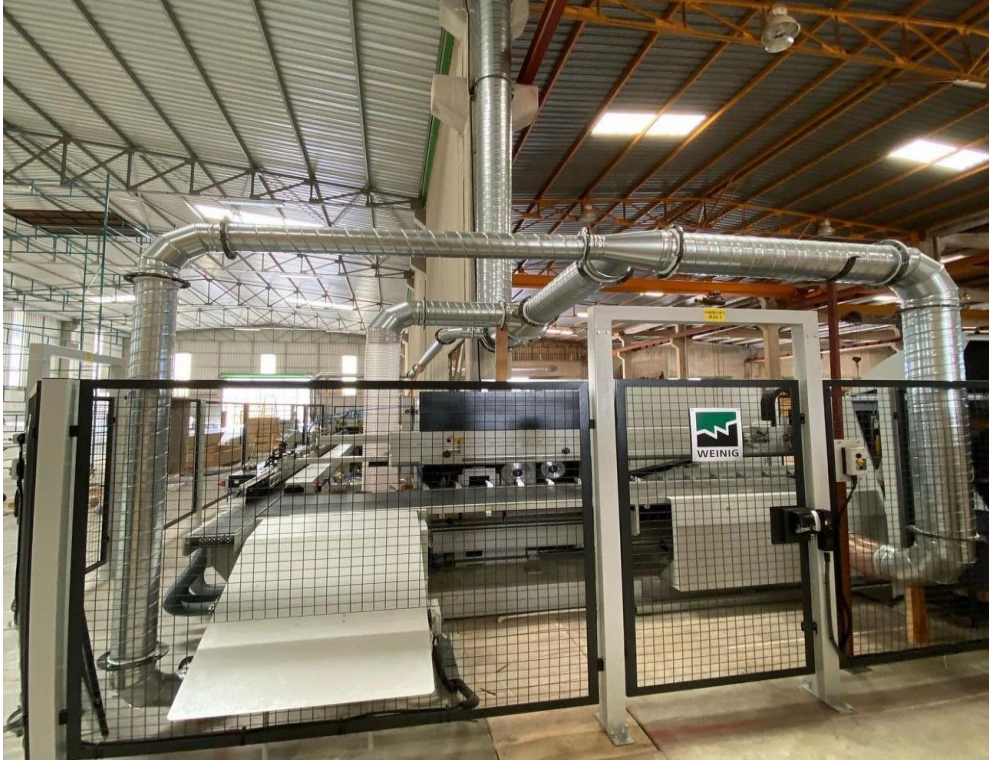
DEMİRAĞLAR ORMAN ÜRÜNLERİ – HSOSB ADANA Havalandırma ve Talaş Toplama Sistemi
